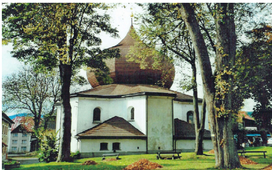
Die Kirche in Markt Eisenstein wurde Mitte des 18. Jahrhunderts in der Grundform eines 6-Hafenofens erbaut
