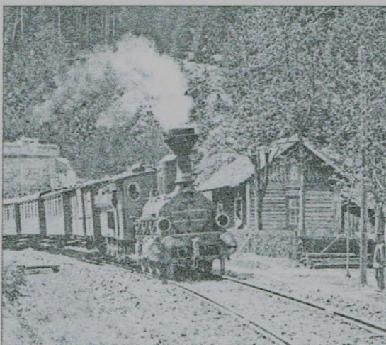
Ein Zug kommt aus dem Spitzbergtunnel (1905).
